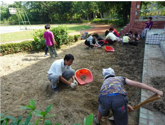
照片說明：整地
