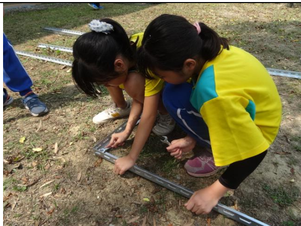
照片簡述:實際開始組裝棚架
