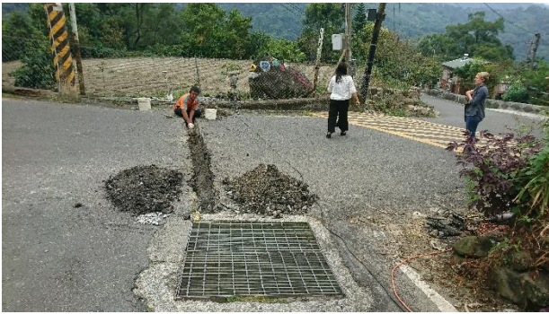
說明：灌溉系統工程施作
